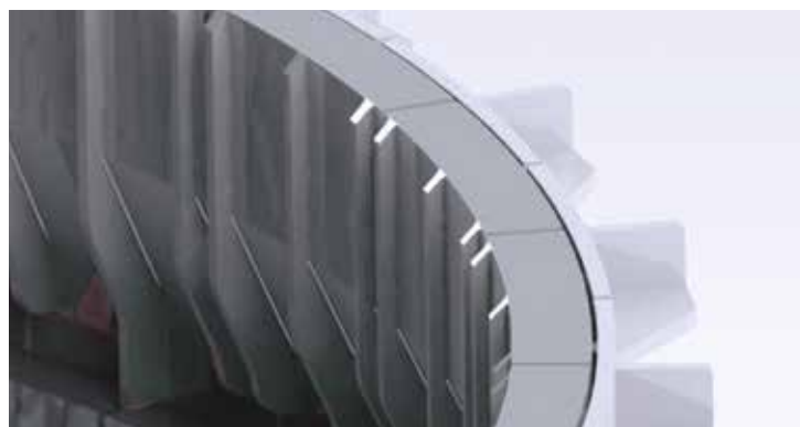
Detalle del sistema de fijación y refuerzo de las placas
